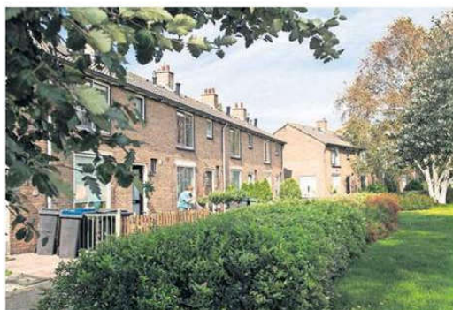
De woningen aan de zuidkant van het dorp FOTO UNITED PHOTOS/TOUSSAINT KLUITERS
